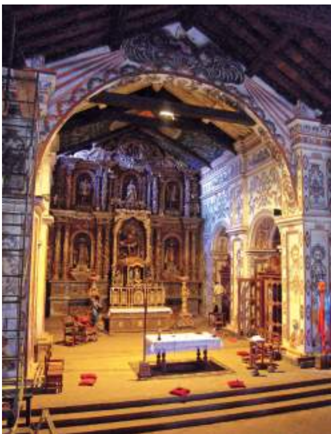
Fig. 8. Arco triunfal de San Miguel. Nótese el arco de ladrillo y los escalones de la plataforma, (fotografía: Víctor Hugo Limpías, 2016).
